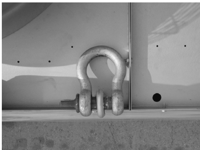
Figure 1: Utiliser des fers pour soulever l'unité.
