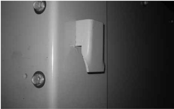
Figure 14: Guides mâles de la section batterie
