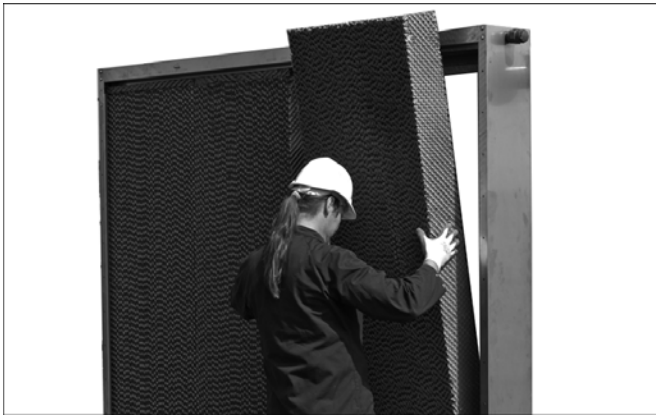
Figure 15: Démontage du média du pré-refroidisseur
