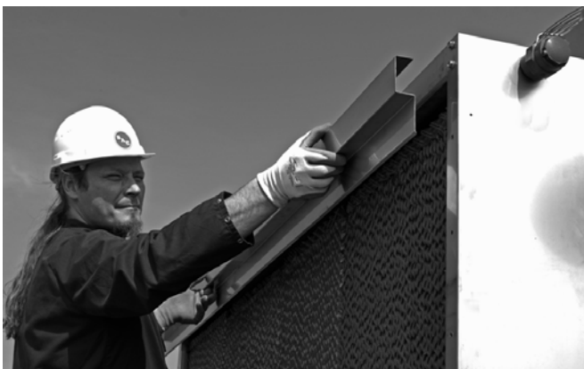
Figure 29: Réinstallation de la plaque supérieure
