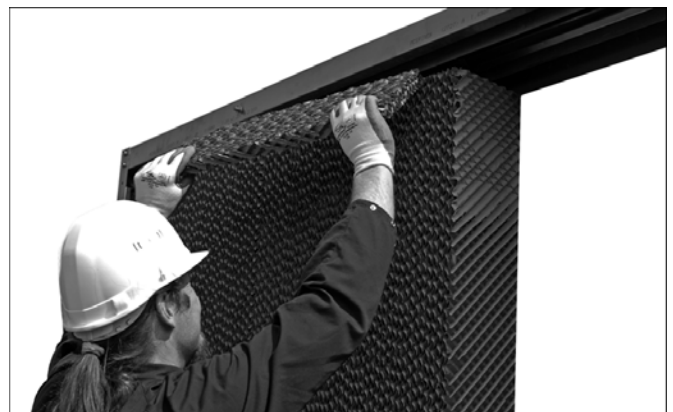
Figure 14: Démontage du média de distribution d'eau vert
