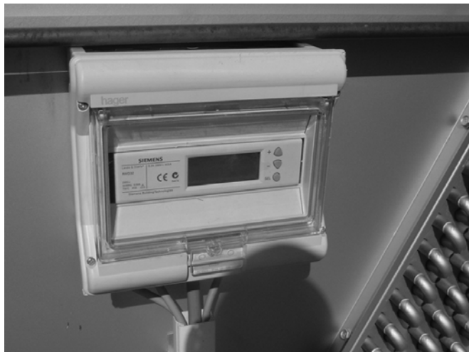
Figure 34: Coffret de commande avec modulation de capacité
