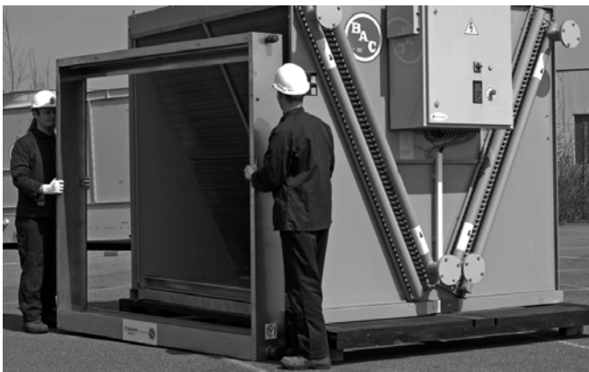
Figure 17: Installation du cadre vide du pré-refroidisseur sur l'aéroréfrigérant .
