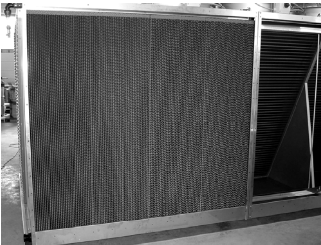
Figure 28: Poursuivre l'installation du média du pré-refroidisseur
