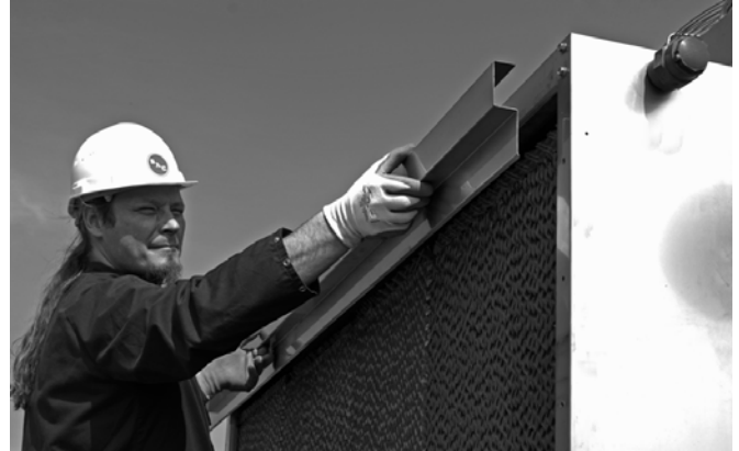
Figure 12: Démontage de la plaque supérieure
