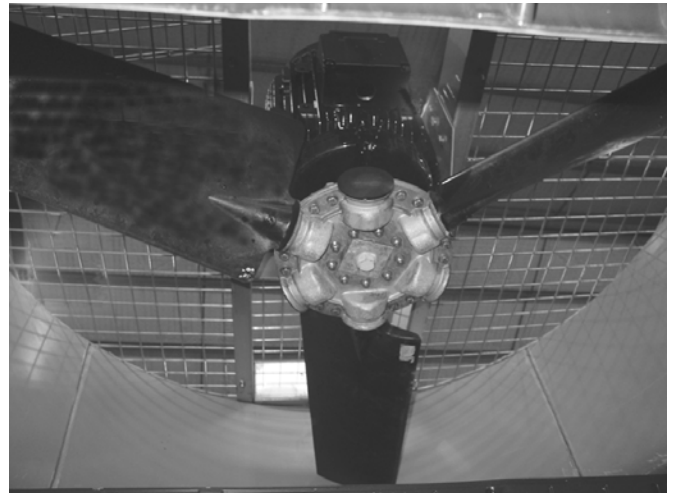
Figure 13: Ventilateur axial sur appareil à entraînement direct
