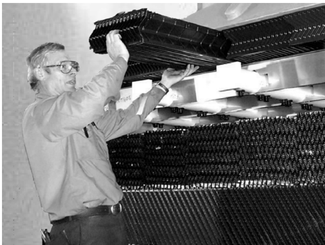
Figure 9: Éliminateurs de gouttelettes démontables
