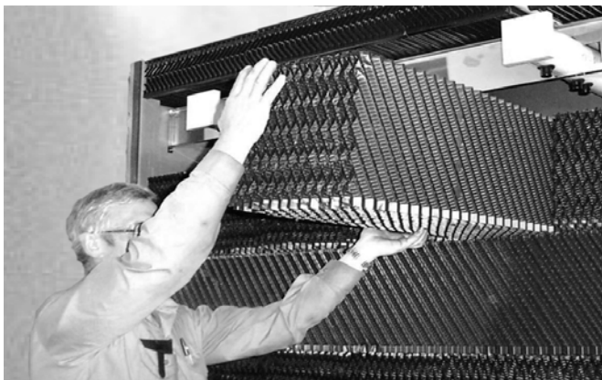
Figure 8: Surface de ruissellement démontable
