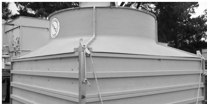
Figure 14: Points d'ancrage de la porte d'accès.
