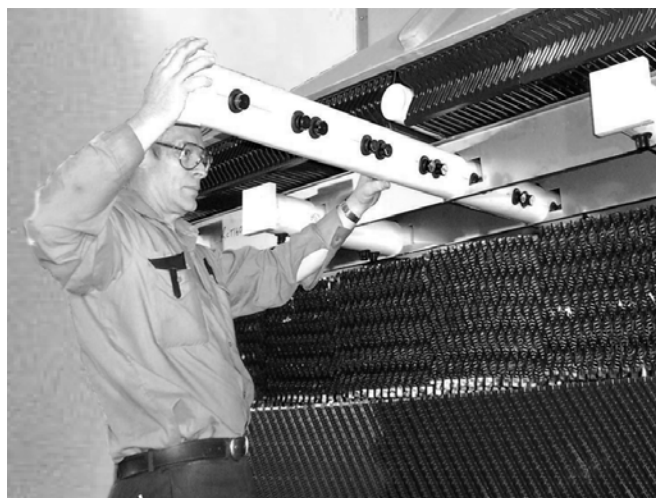
Figure 11: Système de pulvérisation démontable
